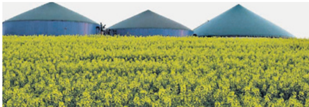
Eine Biogasanlage ist am Ortsrand von Landau geplant: Hühnermist, Mais und Grasschnitt sollen darin verarbeitet werden. Unser Bild zeigt die Anlage bei Volkmarsen. Archivfoto: Elmar Schulten
