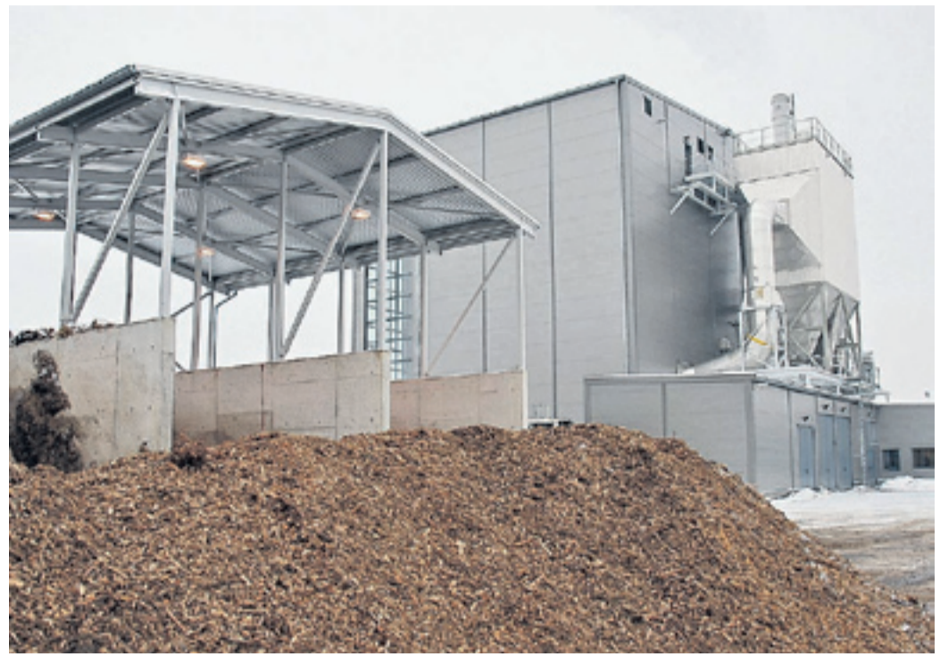
Das Biomasseheizkraftwerk wird mit unbehandeltem Restholz aus dem Wald befeuert. Fotos: Armin Haß
